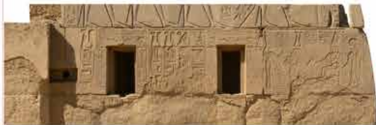
d. Niches du tableau ouest de la porte du 7 e pylône
