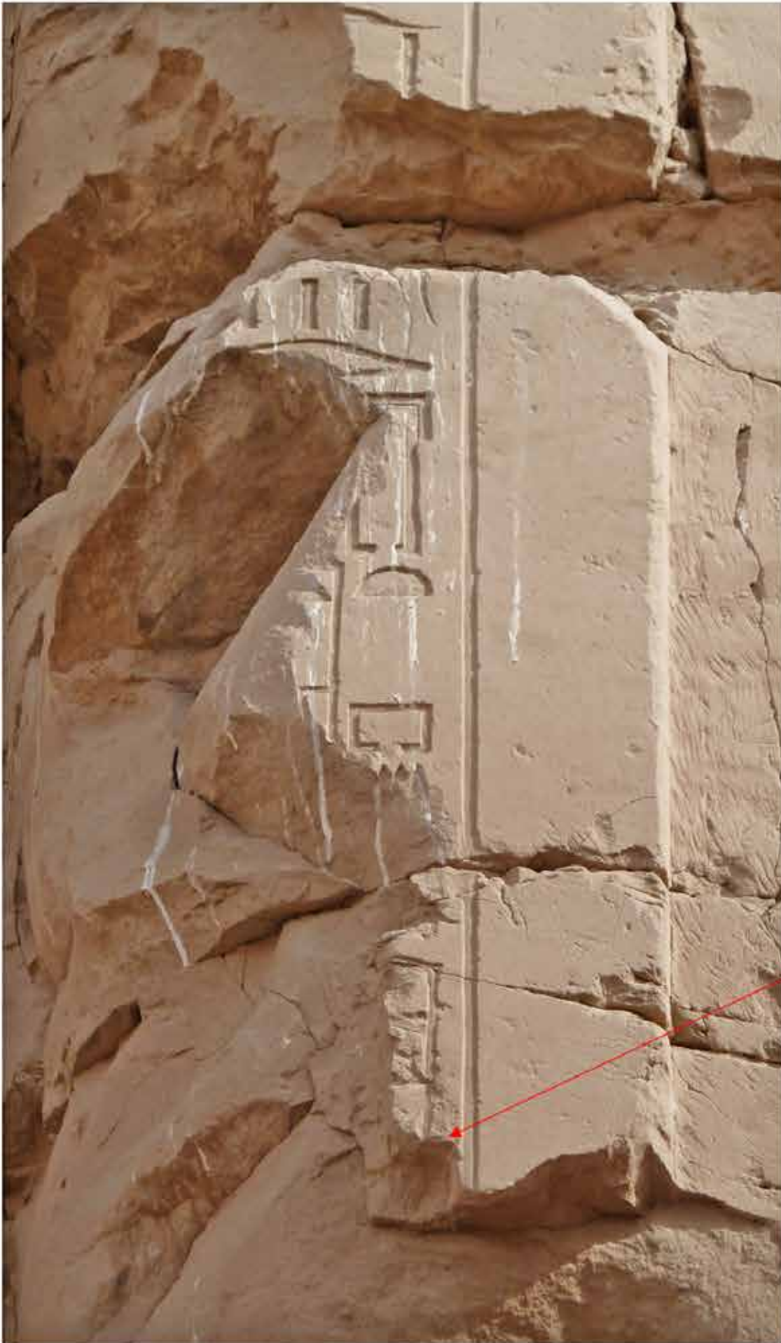
a. Mention de Rw-ty sur le chambranle de niche de mâts du môle ouest du 8 e pylône et sur celui réemployé dans le môle nord du 5 e pylône ainsi que sur la grande porte sud d'Amenhotep I er et sur l'obélisque sud de Thoutmosis I er
