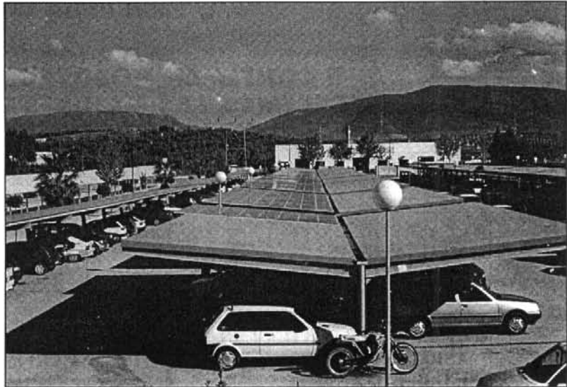
Paneles fotovoltaicos en el aparcamiento de la Universidad de Jaén.
