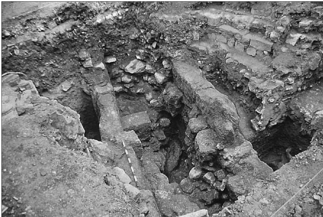
Lámina 6. Muralla romana de la calle Borja. Detalle del relleno interno.
