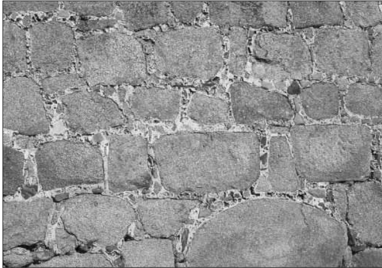
Lámina 6. Detalle de las fábricas encintadas del frente meridional de la madina de Vascos (Toledo). Obsérvese la inclusión de numerosos fragmentos cerámicos colocados de cara”
