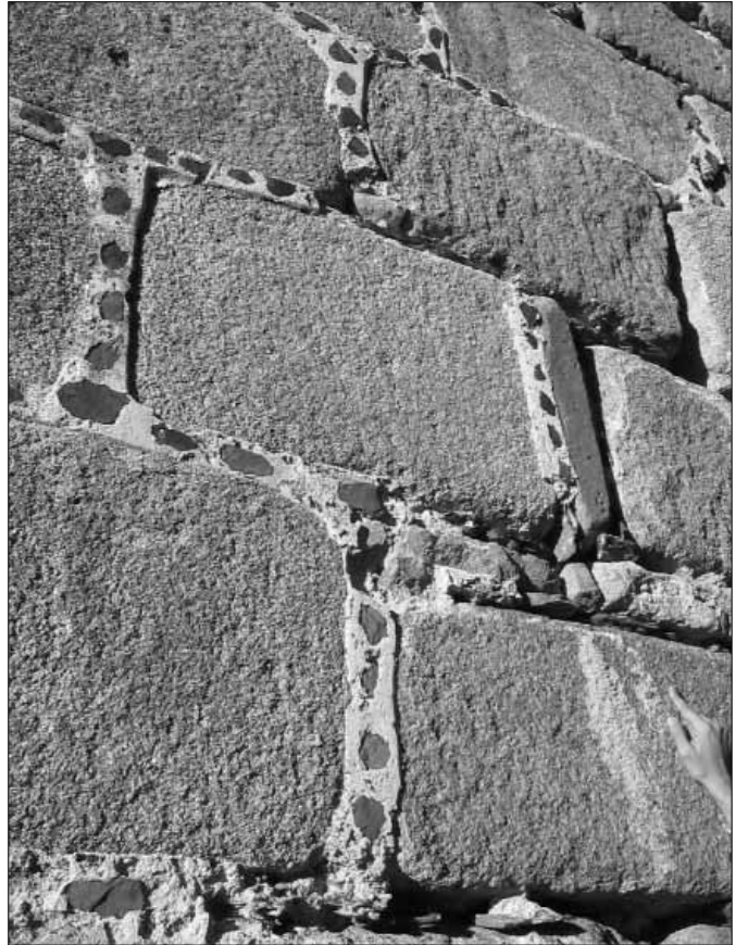
Lámina 4. Detalle de las sillerías encintadas en el castillo de Trujillo (Cáceres).
