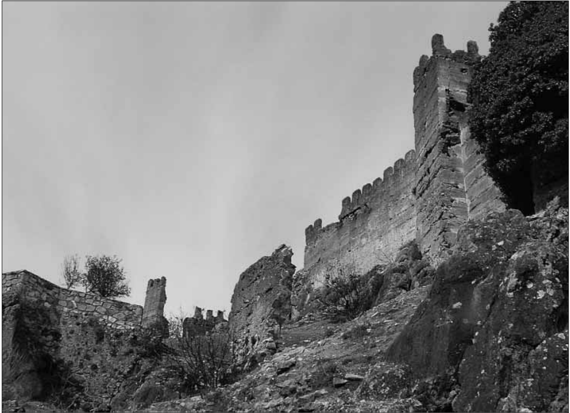
Lam. 75. Muro Sur desde el Sureste
