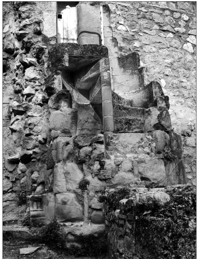
Lam. 32. Escalera de acceso al campanario
