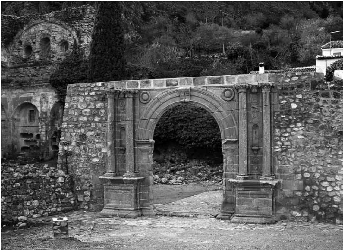
Lam. 30. Fachada principal
