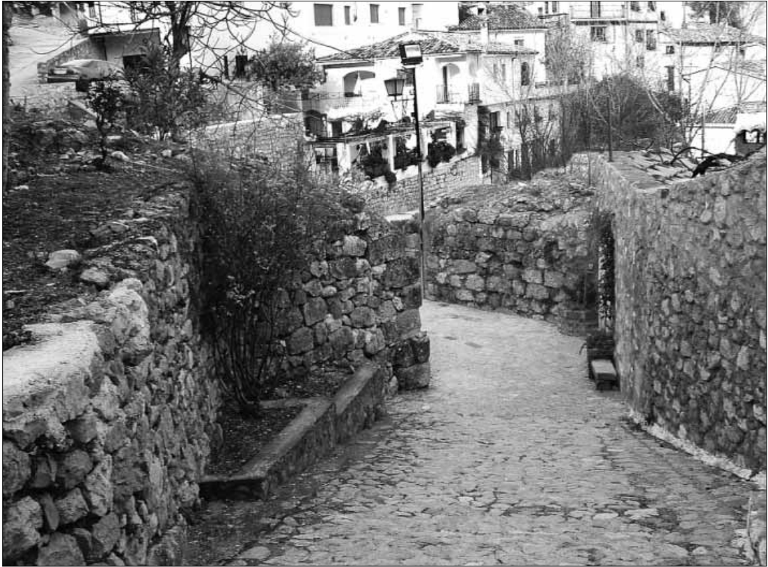
Lam. 7. Acceso al Recinto Exterior
