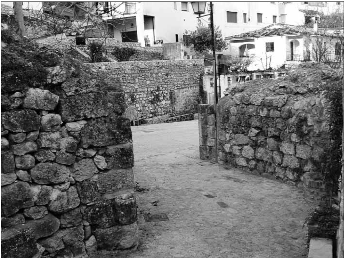
Lam. 8. Acceso al Recinto Exterior. Detalle
