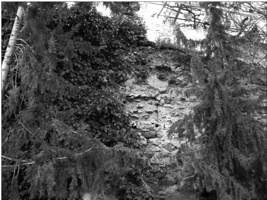
Lam. 4. El muro Oeste del Recinto Exterior. Detalle
