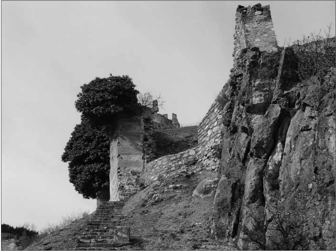
Lam. 63. Extremo Este de la muralla
