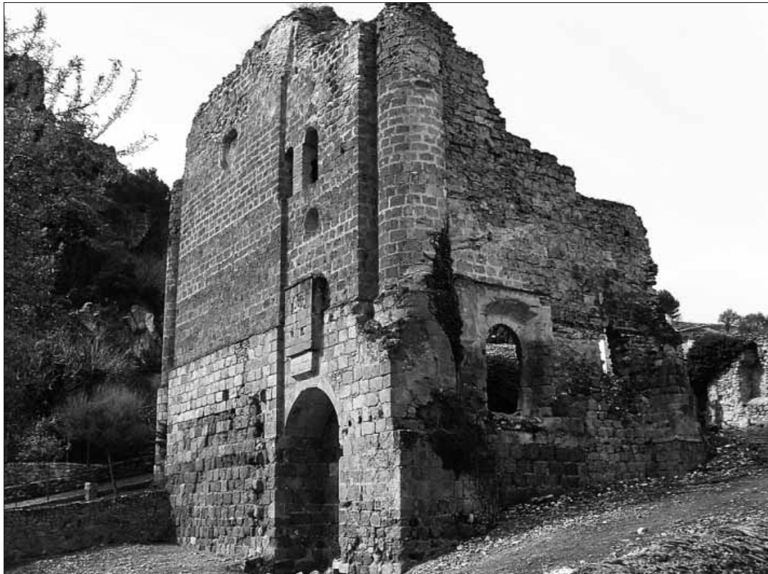
Lam. 26. Puerta del Crucero Norte. Exterior
