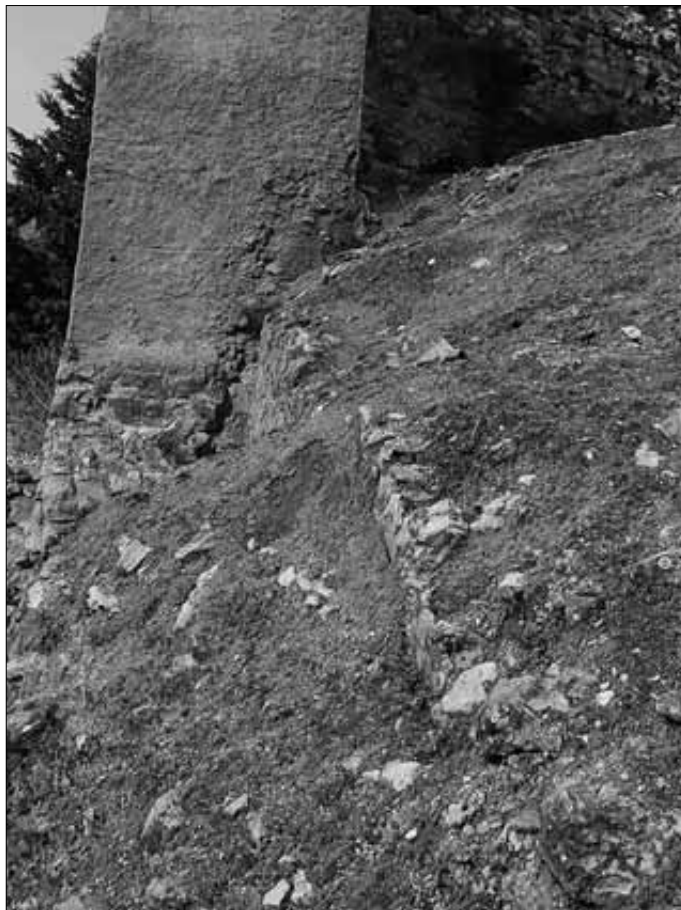
Lam. 77. Muro Sur junto a la Torre VI
