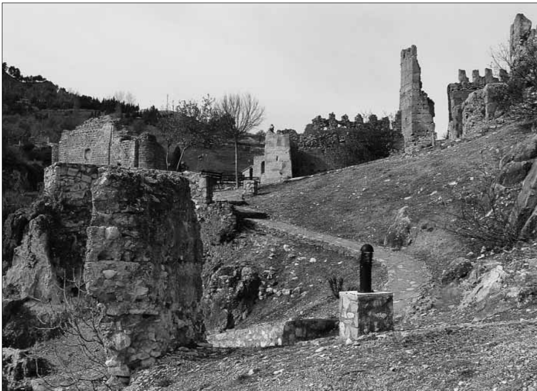
Lam. 76. Muro Sur. Detalle
