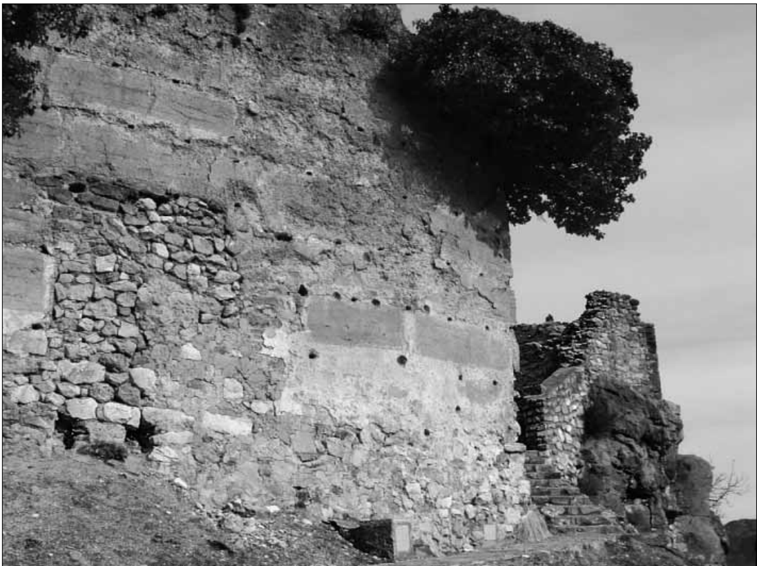
Lam. 64. Alteraciones en la muralla desde el Sur
