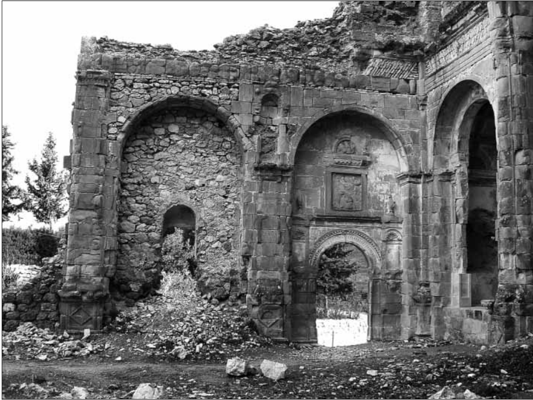
Lam. 23. Muro del Crucero Norte
