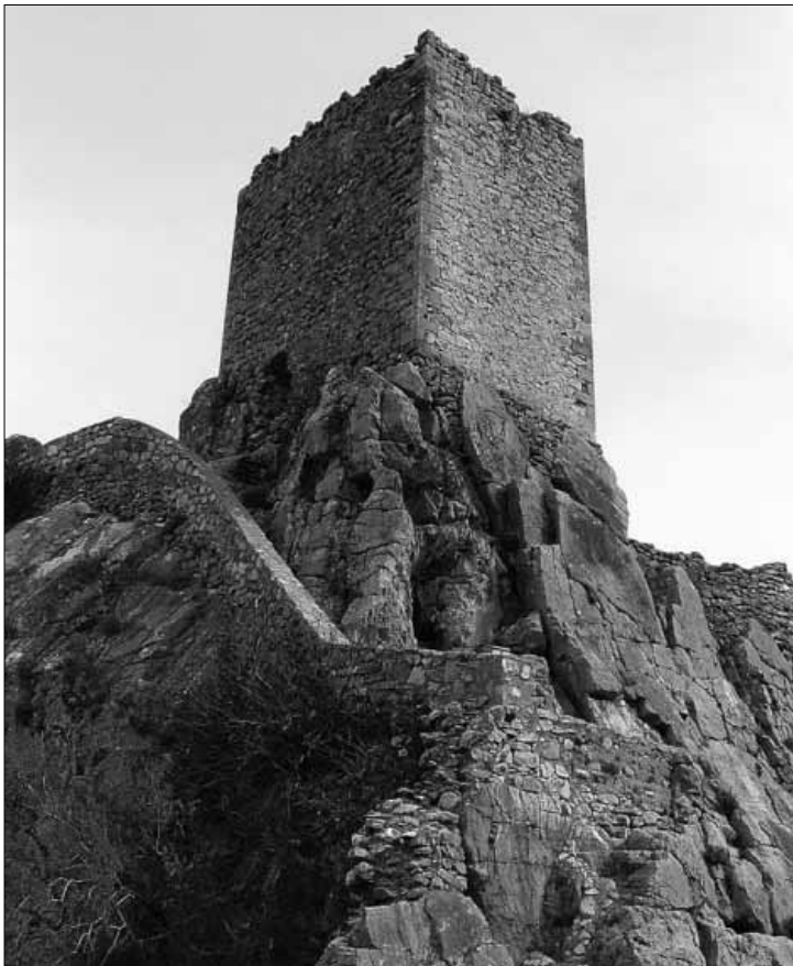
Lam. 72. Torre del picacho y escalera de acceso moderna
