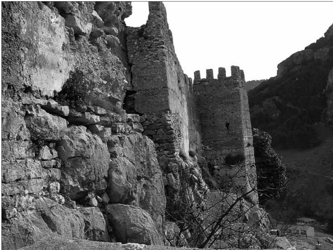
Lam. 58. Exterior de la Torre IV desde el Oeste
