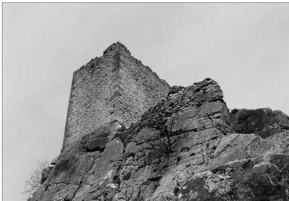
Lam. 66. Alcázar Almohade. Muro de la habitación desde el exterior
