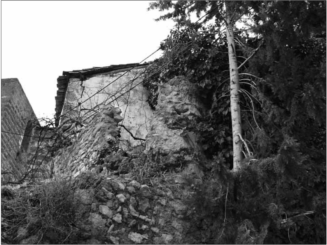
Lam. 3. El muro Oeste del Recinto Exterior. Detalle
