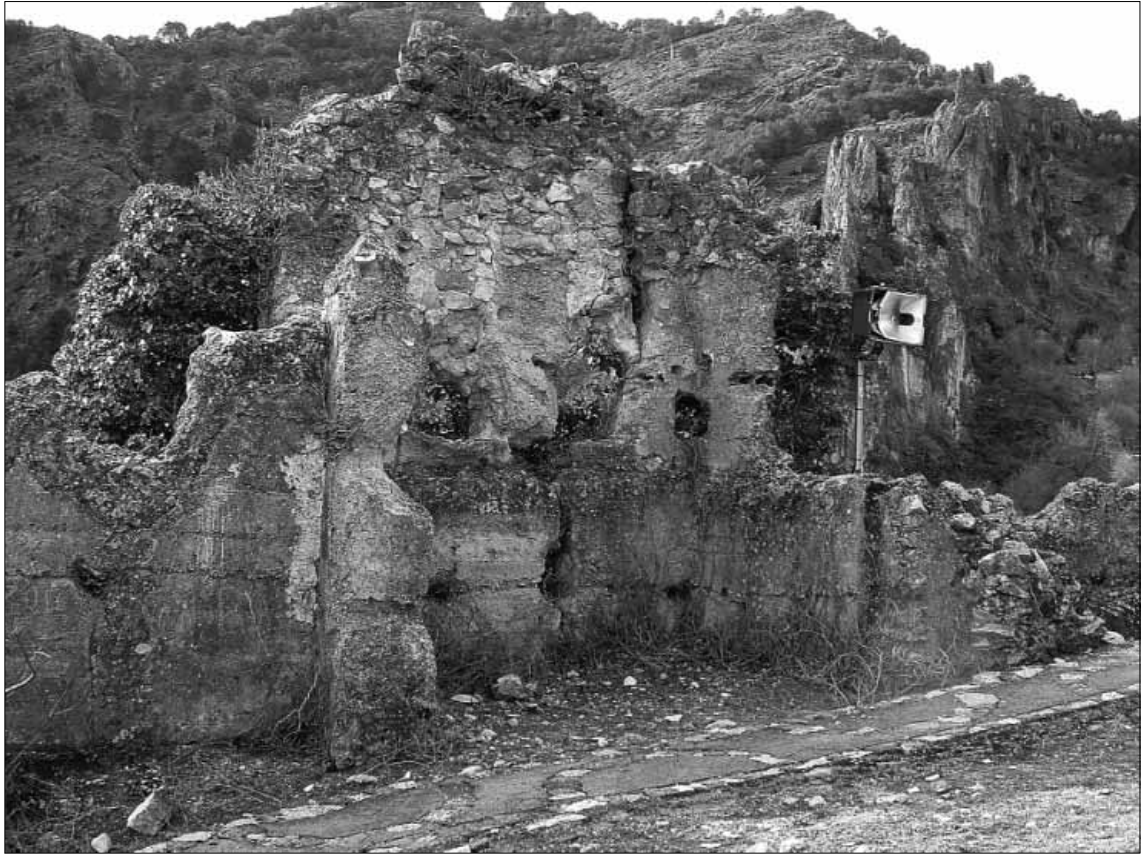
Lam. 59. Restos de la Torre V por al lado Norte
