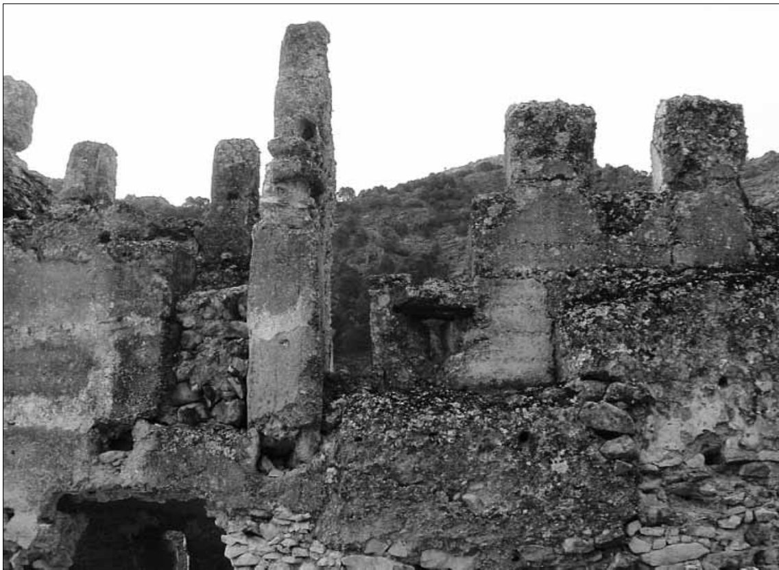
Lam. 50. Saetera en la muralla desde el 2º Recinto
