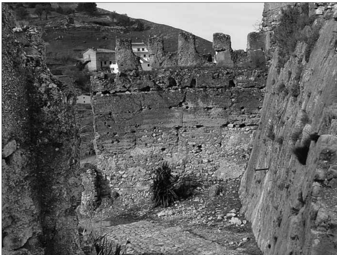
Lam. 42. Patio de acceso. Al fondo la muralla entre las torres I y II. A la derecha la roca sobre la que se asienta la Torre I. A la izquierda en primer plano la Torre III.
