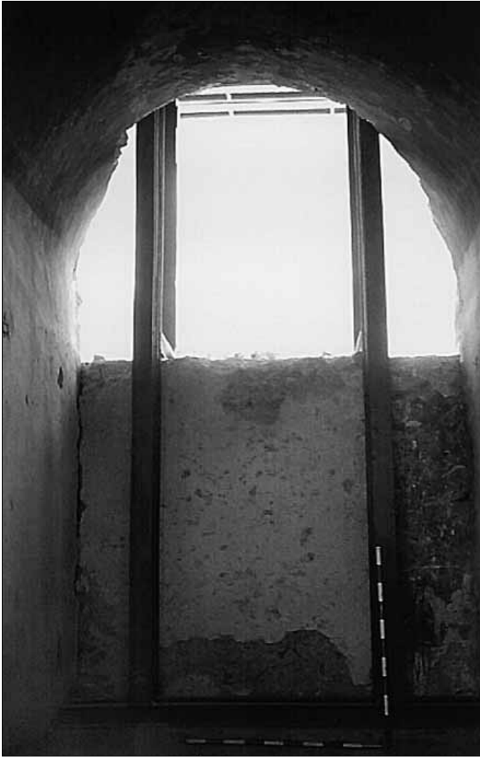
Lam. 3. Interior del Torreón SE.
