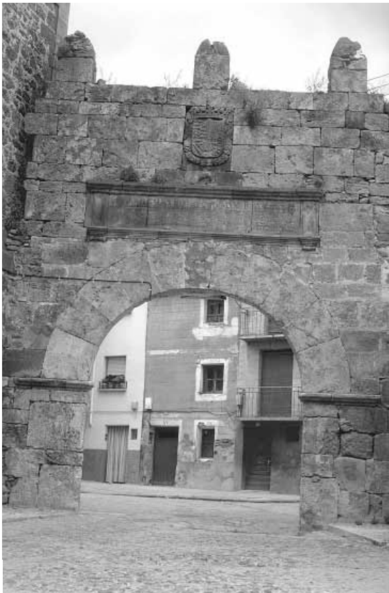
9. El muro de los recintos exteriores se componía de un alma de tapial y dos caras exteriores de mampostería. 10-11. El arco de los Castejones o de Felipe II se construyó en 1573, con motivo de una reordenación urbanística que contribuyó a acercar los recintos de la Peña y de S. Miguel con el de la Muela
