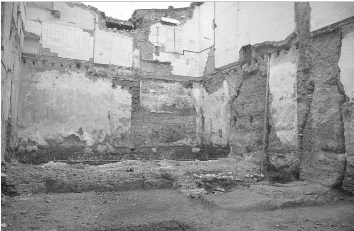
4. Restos de la muralla conservada en las medianerías de las viviendas actuales
