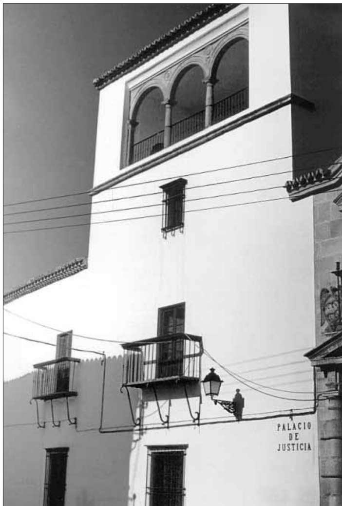
Fig. 12. Mirador de la Casa del Conde de la Quintería.
