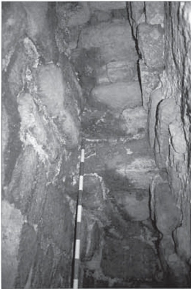
Lámina 5. Bóveda escalonada islámica de losas de piedra sobre ménsulas.
