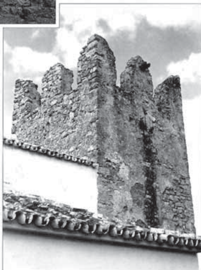
Lámina 8. Detalle de la merlatura de la torre en la esquina E. Se aprecia una aspillera bajo la almena central a la derecha de la imagen.
