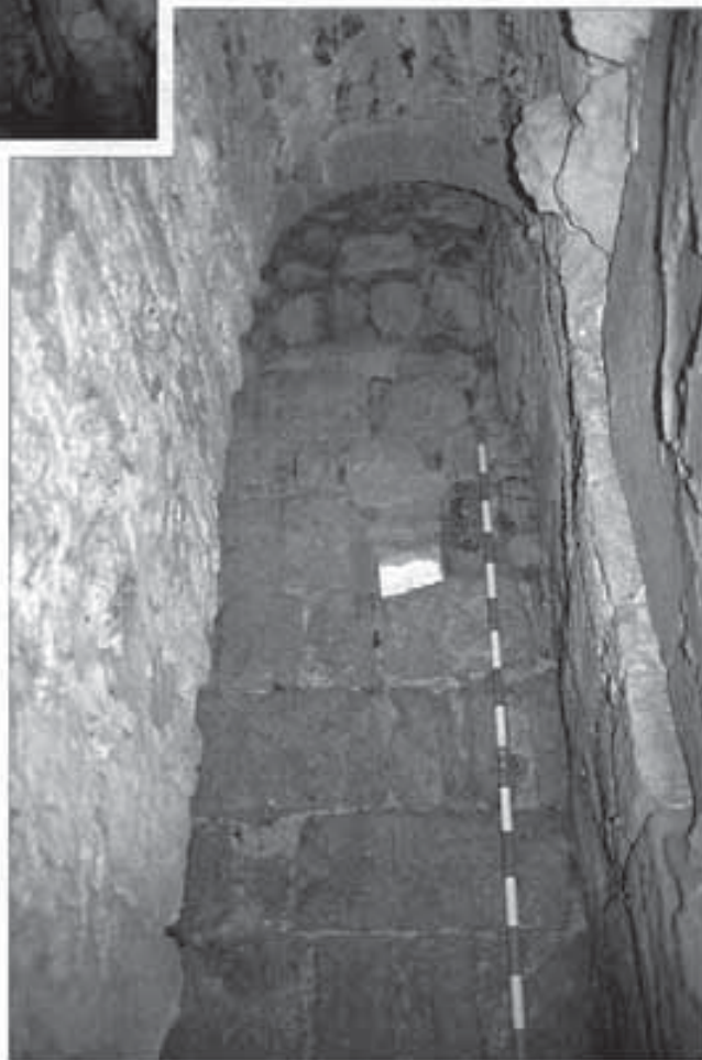
Lámina 6. Bóveda de medio cañón en recrecido sobre la obra primitiva islámica.
