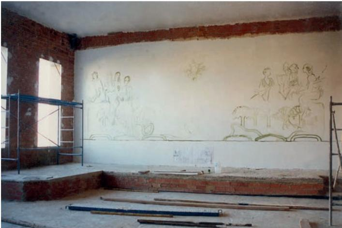
Tras la preparación del soporte con la aplicación sobre el muro de ladrillo desnudo del mortero a la cal, el dibujo de la composición.
