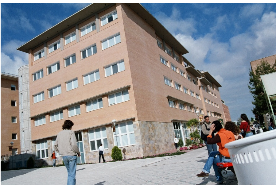
Fotografía Edificio de Ingeniería y Tecnología UJA
