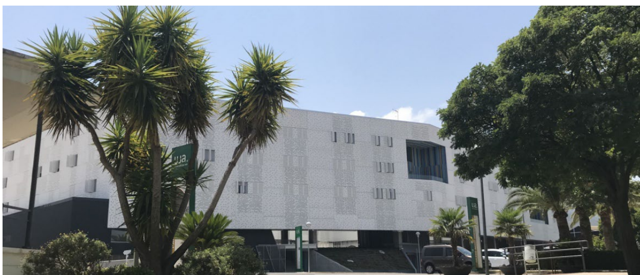
Edificio de alojamientos universitarios con reutilización de aguas grises
