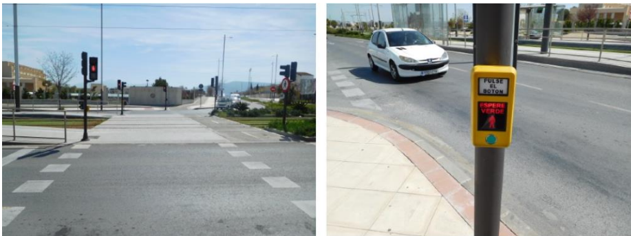
Ilustración 9: Paso peatonal seguro, accesible y con pulsador. Fuente: Elaboración propia
