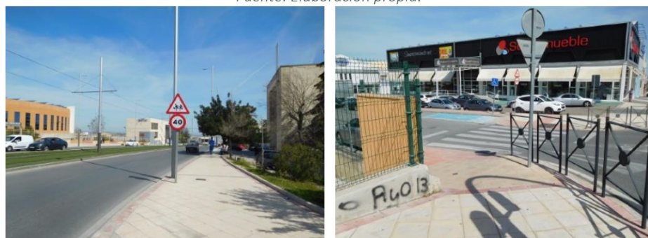
Ilustración 7: Señalización de seguridad y paso peatonal con limitación por fuerte pendiente. Fuente: Elaboración propia.
