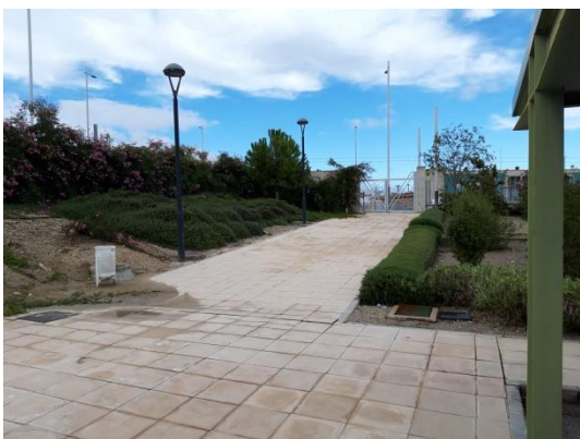
Ilustración 19: Acceso directo a la estación del Tranvía. Fuente: Elaboración propia
