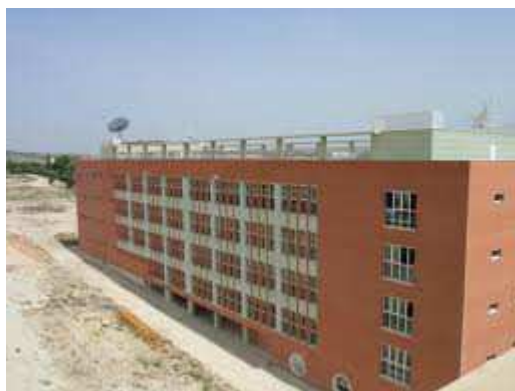
EDIFICIO A2 EN EL CAMPUS UNIVERSITARIO DE DE LAS LAGUNILLAS LA UNIVERSIDAD DE JAEN. JAEN.
