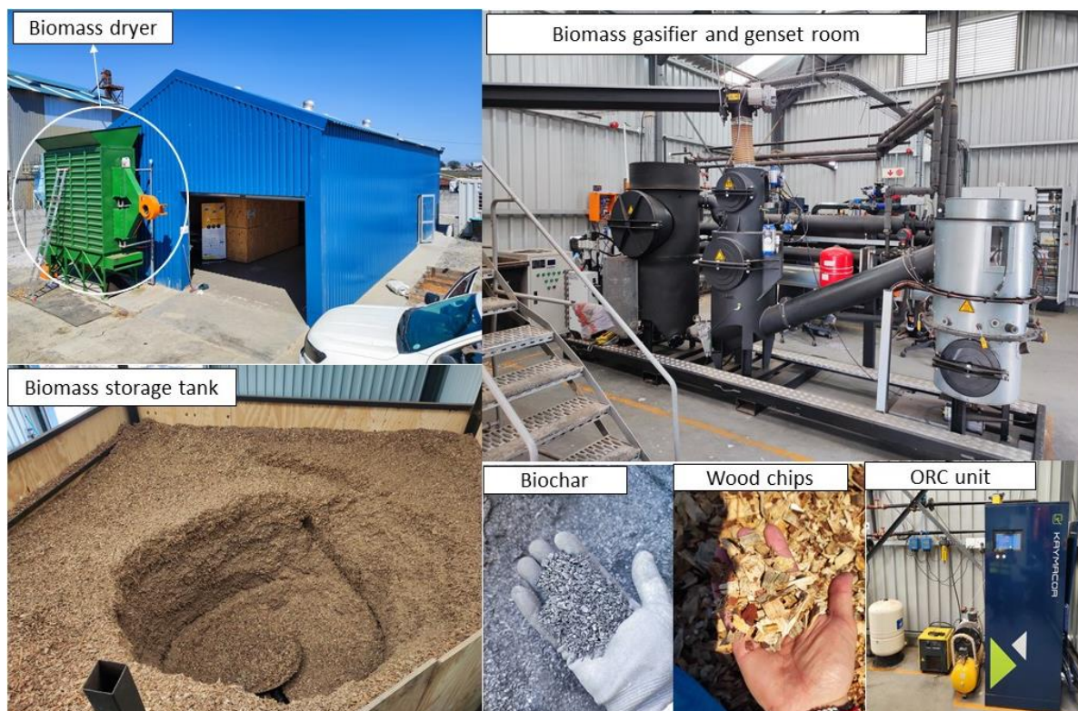
Figura 2. Planta de energía en Sudáfrica.
